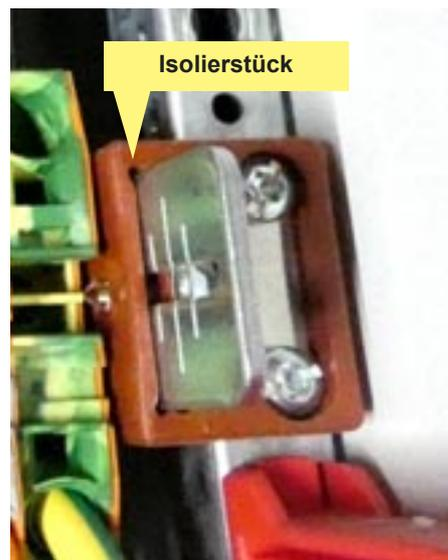
**Hutschiene isoliert montiert**
